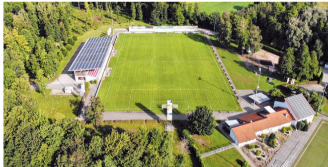
Die Mitglieder des FV Neufra haben in den vergangenen zwei Jahren im Waldstadion etliche Baumaßnahmen gestemmt - hauptsächlich in Eigenleistung.
